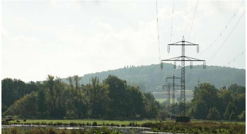
Freileitung des Netzbetreibers Westnetz, die durch ein Vogelschutzgebiet verläuft und bereits mit verschiedenen Vogelschutzarmaturarten ausgestattet wurde (Fröndenberg/Ruhr, 2022).
