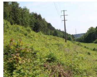
Etat initial avant travaux (le 2016-06-17)
