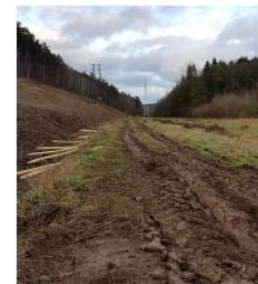
Action LIFE : pose de clôtures (le 2018-12-19)
